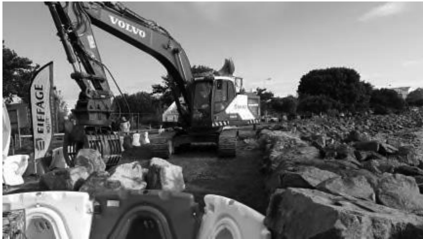
Figure 16 : Pose d'une couche de protection en enrochements
